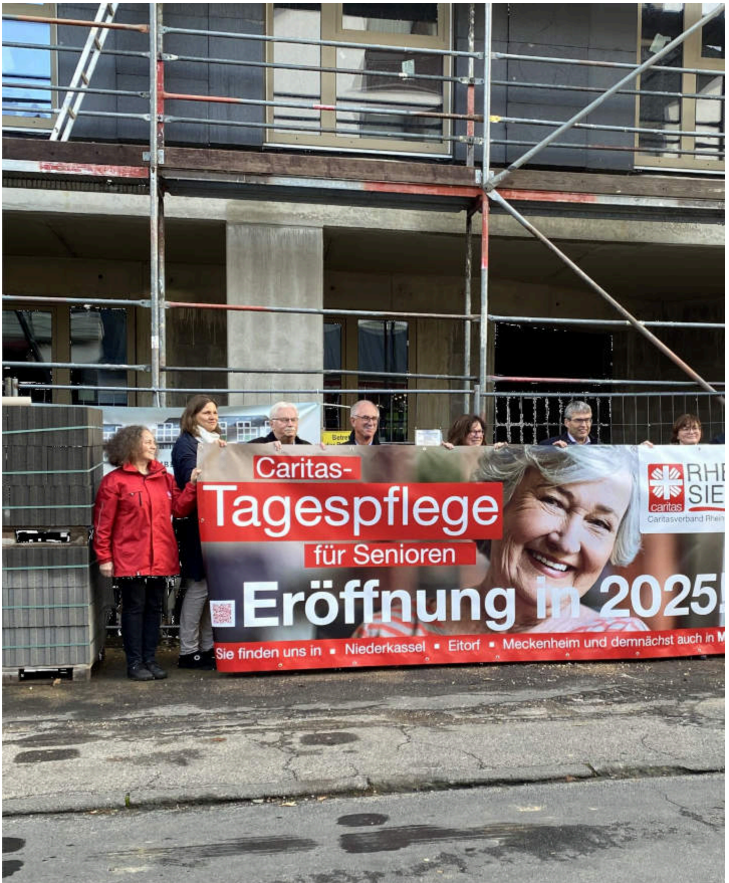
MUCH. Hell und luftig wird der Aufenthaltsraum werden, licht auch die Ruheräume: Noch befindet sich die Caritas-Tagespflege für Senioren in Much im Rohbau. Doch schon jetzt ist erkennbar, wie gut die Pläne des Investors Robert Höller auf die Anforderungen einer solchen Einrichtung zugeschnitten sind. Hier werden Pflege und Betreuung nach neuesten
